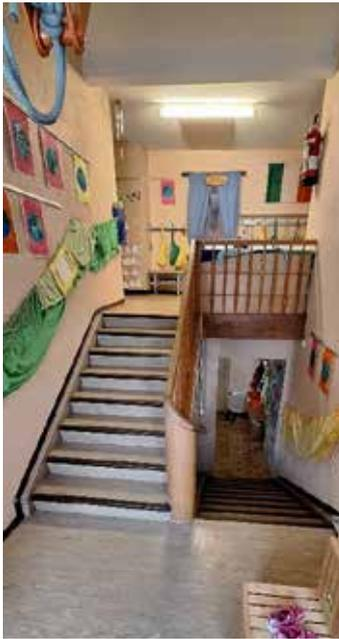
Das Treppenhaus, welches zu einem Drittel aus Holztreppe besteht, weist sicherheitstechnisch eine zu enge Durchgangsbreite und über alle Etagen ein zu niedriges Geländer aus. Das Gebäude ist nicht behindertengerecht ausgestattet.
