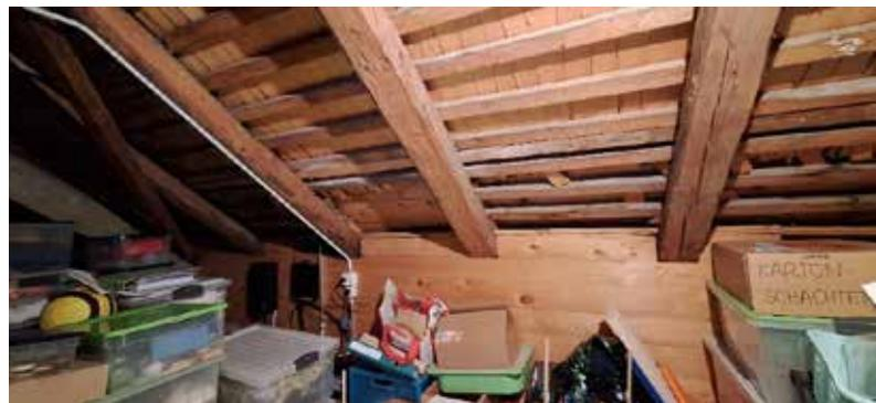
Das Dach besitzt ein Schindelunterdach welches den Zweck bis heute erfüllt, jedoch ist die Dachhaut sanierungsbedürftig. Im Winter entstehen durch austretende Wärme Schwellwasser und Eiszapfen.
